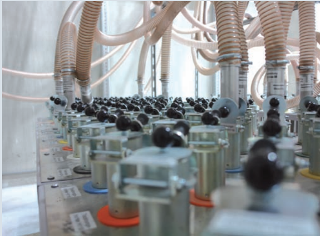
Herzstück der Anlage ist der zweigeteilte Kupplungsbahnhof.
