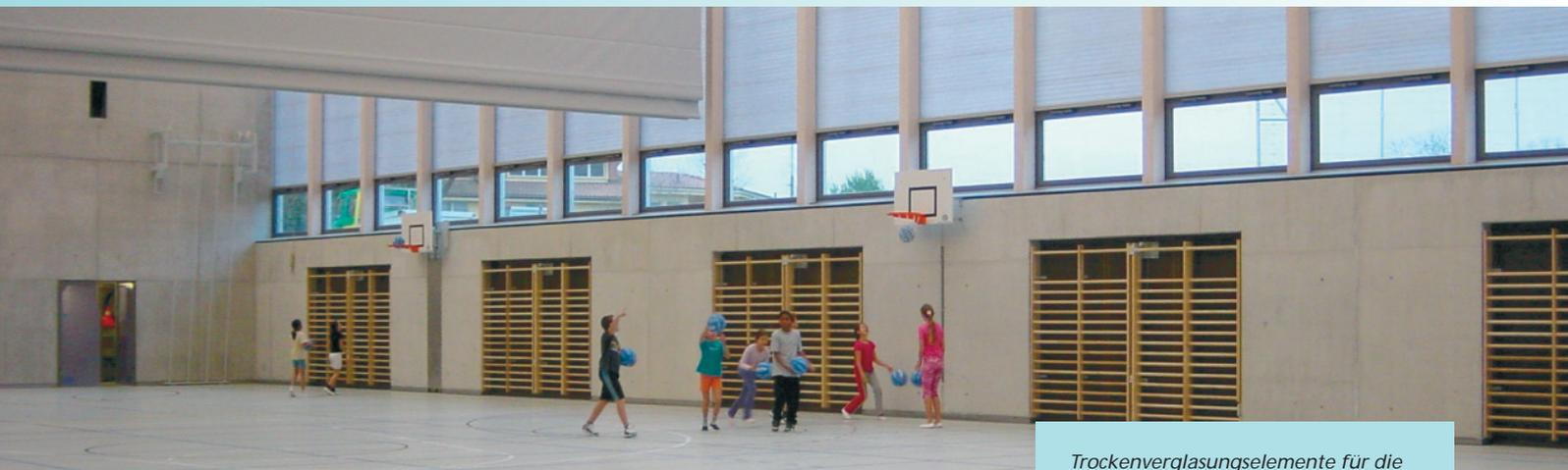
*Trockenverglasungselemente für die Sporthalle der Züricher Schulanlage Buchwiesen sind wärme- und schalldämmend und sorgen für gute Lichtstreuung.*
